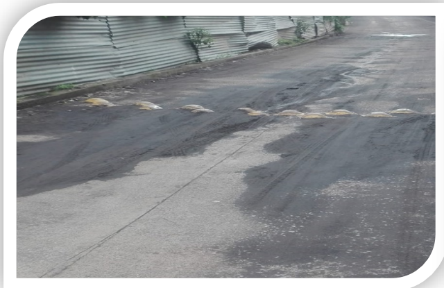
Reparación de hundimiento
