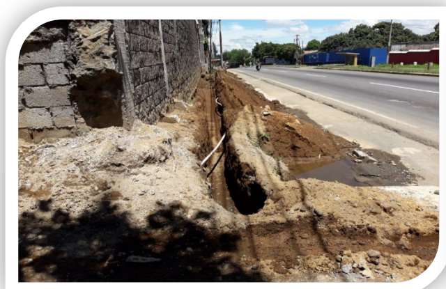
Implementación de tubería para abastecimiento de agua potable
